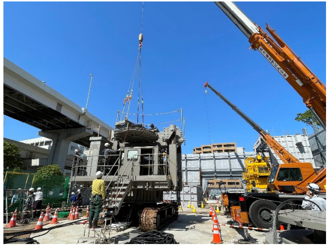
掘削機組立状況
