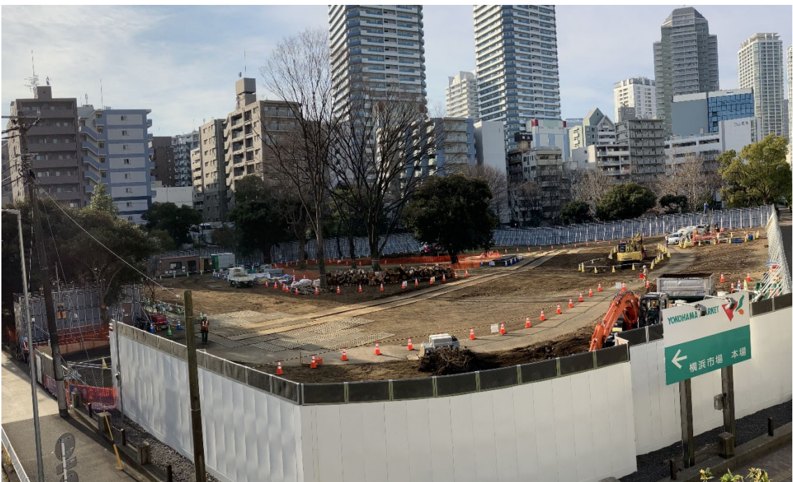
2024年2月 仮囲い設置・場内整地
