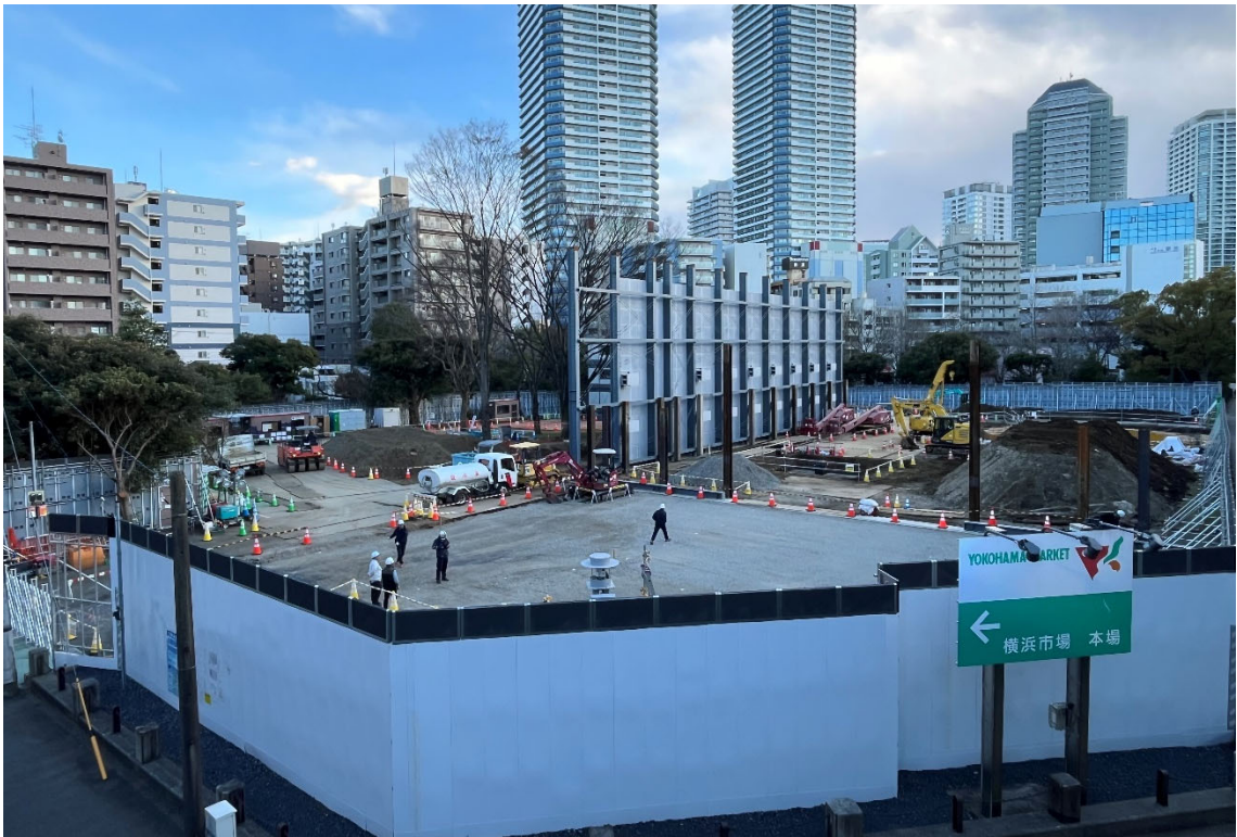
2024年4月 場内舗装
