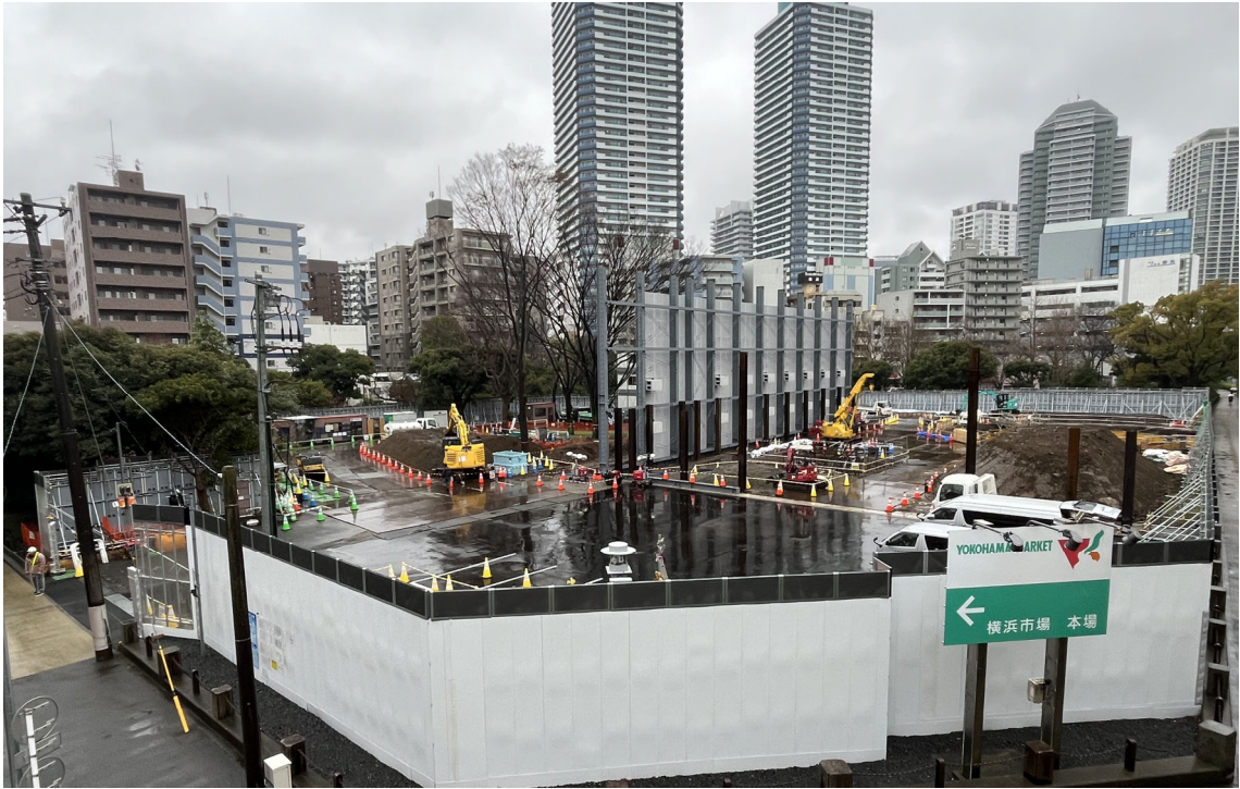
2024年3月 防音壁組立
